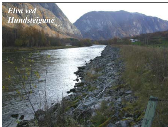
Fig. 28. Lærdalselva ved Hundsteigane og Grøtøyane med elveslette i bakkant gir antatt innsig av grunnvann gjennom elveforbygning av grove masser. Ved Grøtøyane er elvesletta preget av våtmark med oreskog, med grunnvannspregete grøfter. Inn i dette våtmarksområdet renner også Skorva og Labbegjelfossen.
