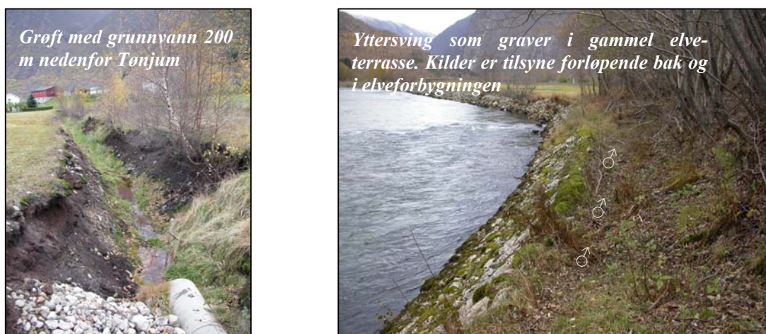
Fig. 31. Venstre: 200 m nedenfor Tønjum kommer grunnvannskilder fortløpende tilsyne i drengrofter ved hovedveien, og de kommer tilsyne (markert) i nedkant av gammel elveterrasse bak og til dels inne i elveforbygningen (høyre bilde).
