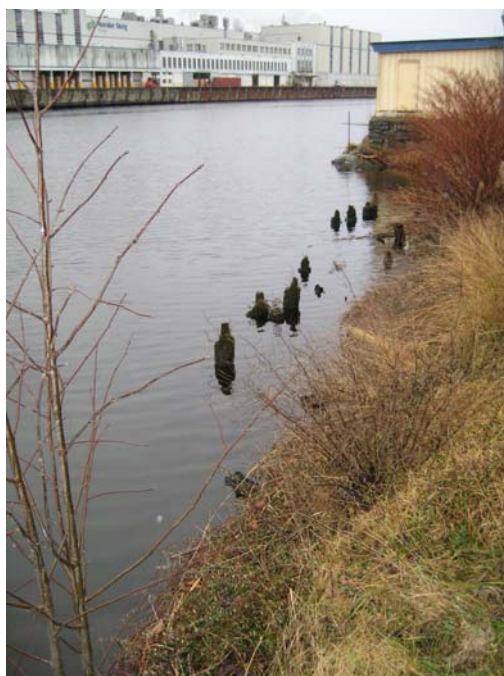
Figur 5b. Strekning med steinfylling ved Follestad
