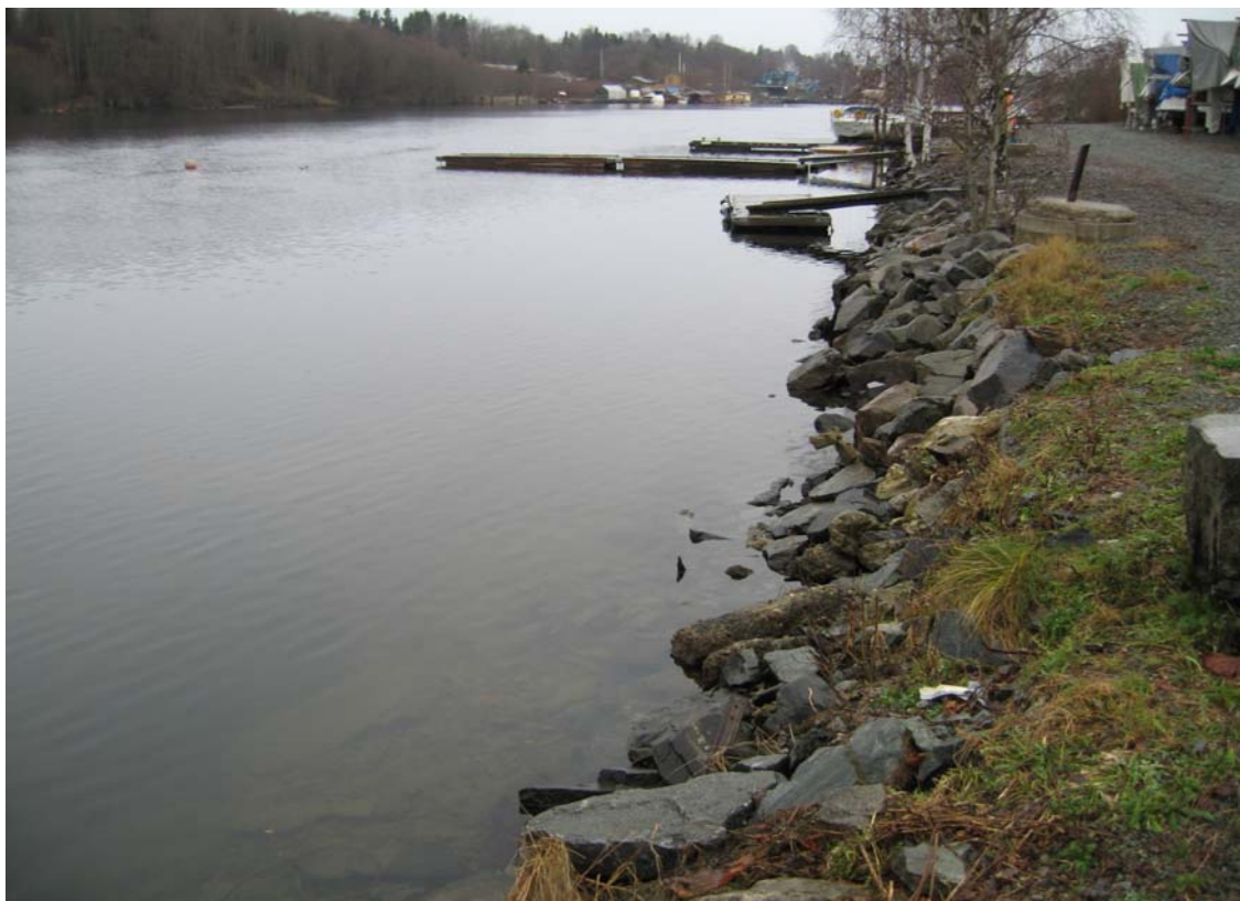
Figur 8a. Oversikt over lokalitet Menstad sett oppstrøms.
