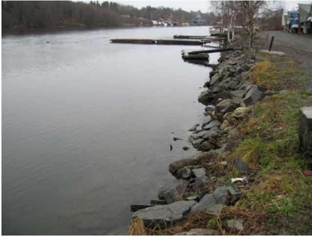
Figur 2a. Nyere steinfylling ved Menstad.
