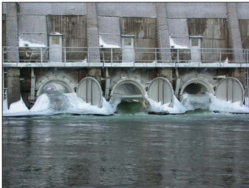
Fig. 1. De tre tappelukene i Pålshudammen sett fra nedsiden. Ved lav vannstand i Pålshufjorden og høy vannstand i Tunhovdfjorden antas det at fisk kan opp gjennom tappelukene og inn i Pålshufjorden. Foto: Åge Brabrand.
