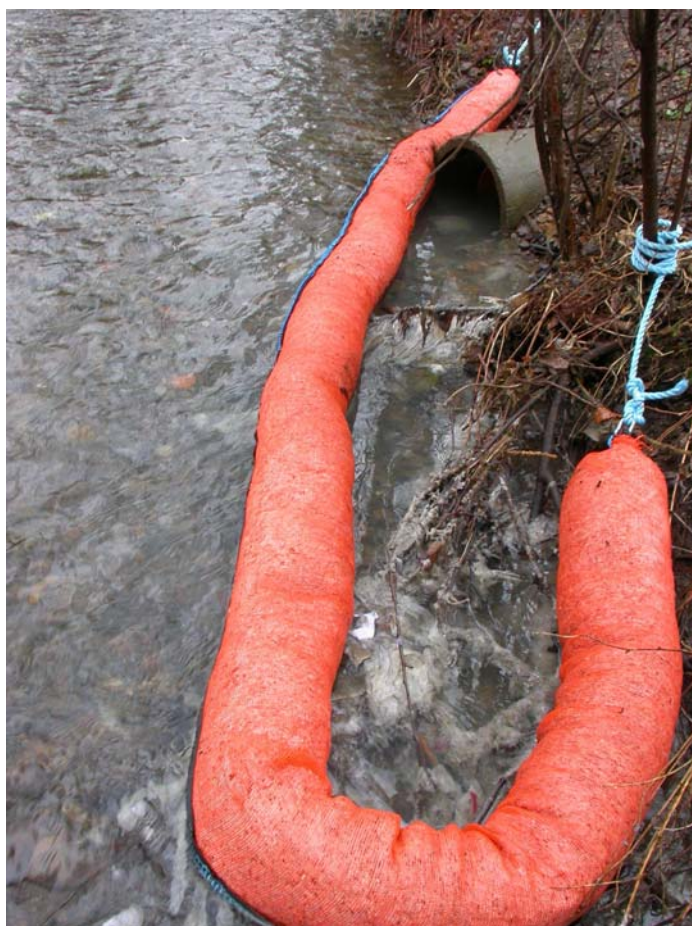
Fig. 2. Overvannsledning som munner ut i Holmenbekken ca 70 m ovenfor Holmendammen. I mars 2010 var det her utslipp av oljerester og kloakk, og oljen ble forsøkt fanget opp av oljelense. Utslipet av kloakk er sannsynlig årsak til at frosk og fisk døde.
