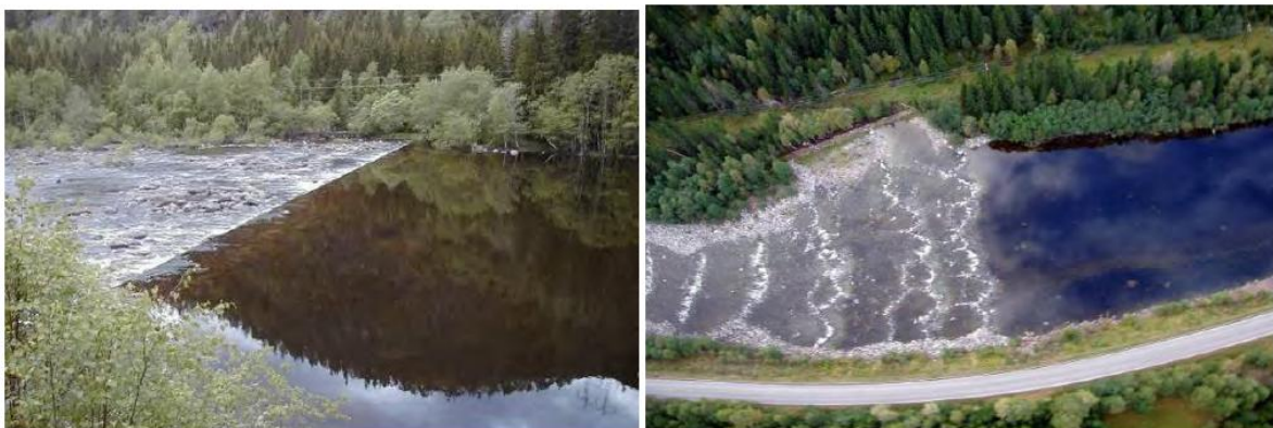
Fig. 41. Bilde av gammel planketerskel (venstre) og samme område etter bygging av celleterskler (høyre). Tatt fra Arnekleiv et al. 2012. Foto: Numedalslågens Brugseierforening.
