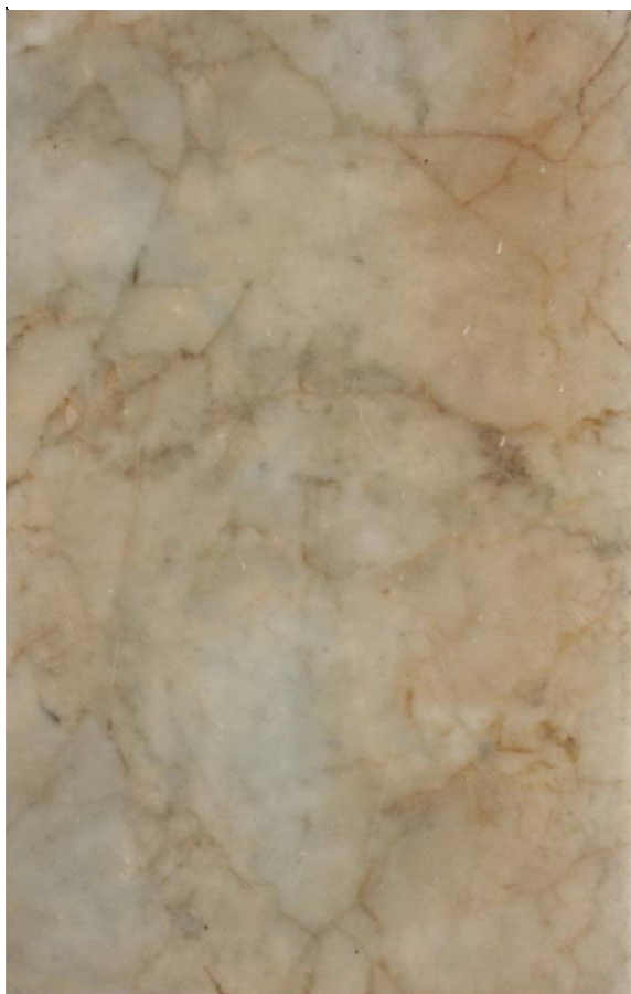
Figur 6. Øverst: Prøvetaking ved å skrape misfarget belegg av plan marmorflate. Nederst: misfargingen er ujevn og varierer med marmorens struktur/tekstur. Foto: E. Roaldset 22.03.2013.
