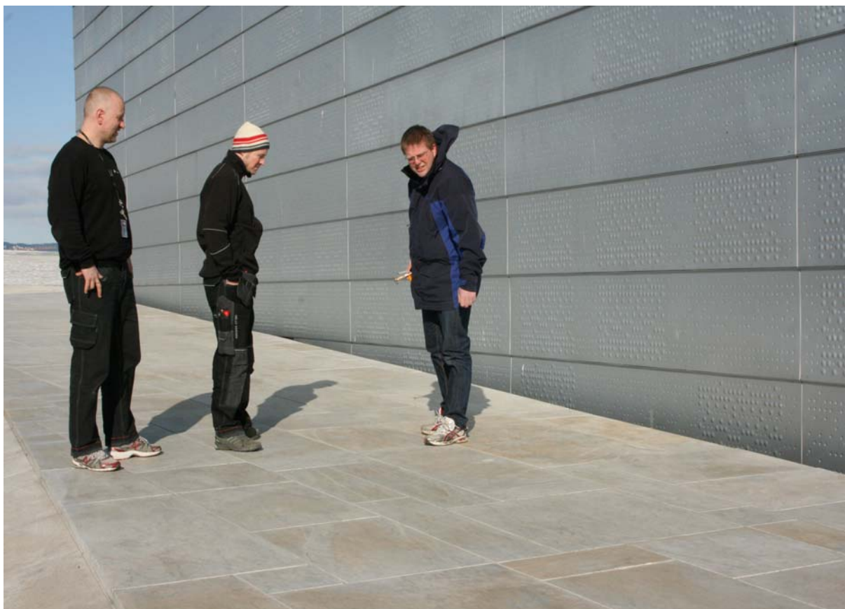
Figur 2. SV-siden av operataket med synlig misfarging. Fra venstre Thomas Fredriksen og Ingar Reinsborg, Statsbygg, og Rune S. Selbekk, Naturhistorisk museum, Universitetet i Oslo. Foto: E. Roaldset 22.03.2013.
