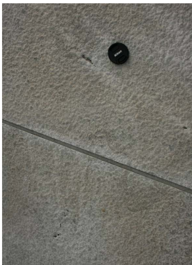
Figur 9 Til venstre: Hans-Jørgen Berg som ved hjelp av kobbertape prøvetar brunt og sort belegg for SEM-EDS analyse. Til høyre: kvartsrike soner med "hull" etter oppløst/forvitret mineral, sannsynligvis gips ( \text{CaSO}_4 \cdot 2\text{H}_2\text{O} ). Foto: E. Roaldset 25.03.2013.
