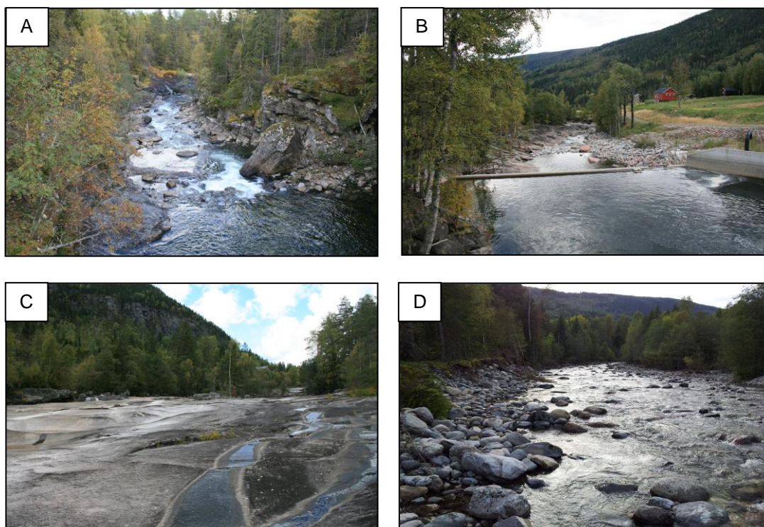
Figur 7. Gøystvassdraget. A: Ovenfor inntaksdam til elvekraftverk. B: Inntaksdam med Gøyst-1 rett nedenfor dam. C: Blankskurt elvebunn mellom Gøyst-1 og Gøyst-2. D: Gøyst 3, nedenfor samtløp med Husevollåe.
