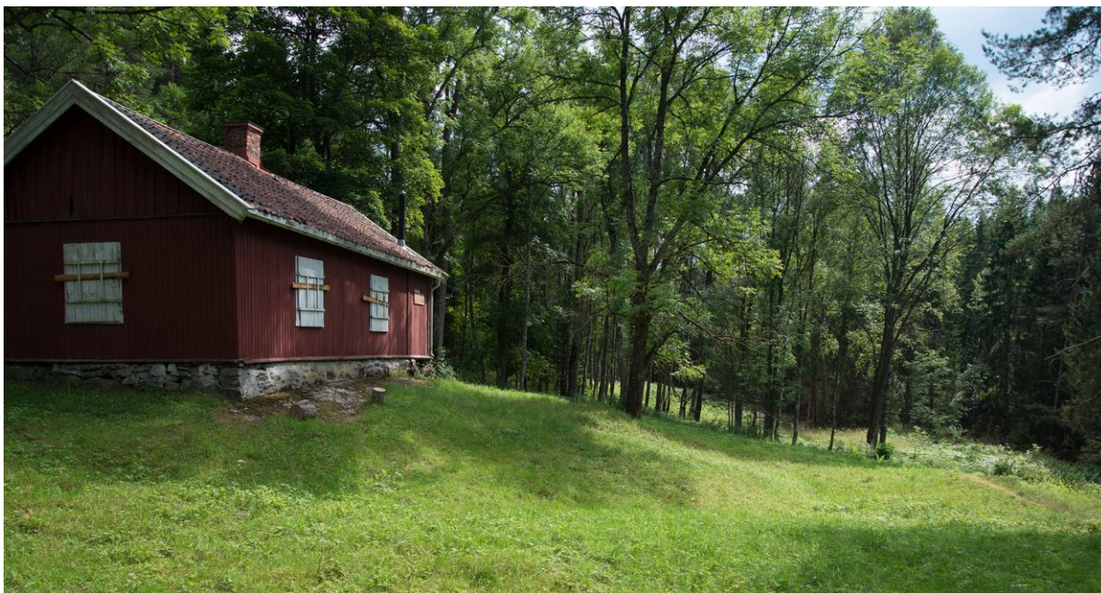
Figur 53. Dølerud er en gammel husmannsplass nær Østmarkkapellet. Gårdsdriften har opphørt, men det er planer om å ta i bruk hytta som ubetjent DNT-hytte. Foto: Hallvard Elven
