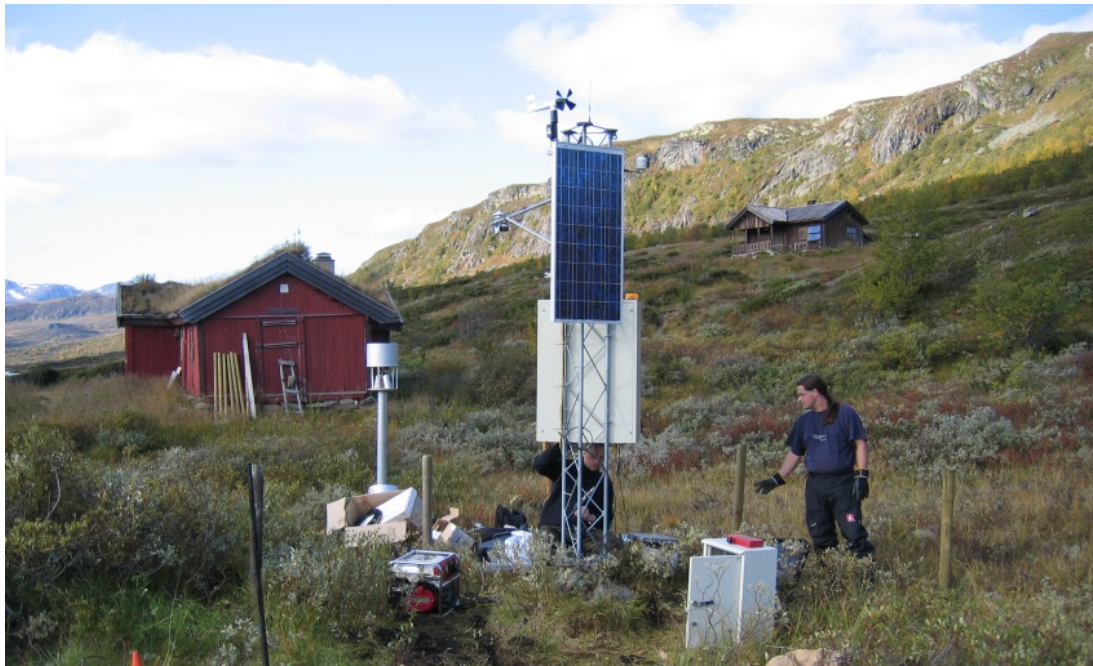
Figur 5. Oppgraderingen på NVEs målestasjonen for vannstand, vanntemperatur, lufttemperatur, vind, nedbør og innstråling.
