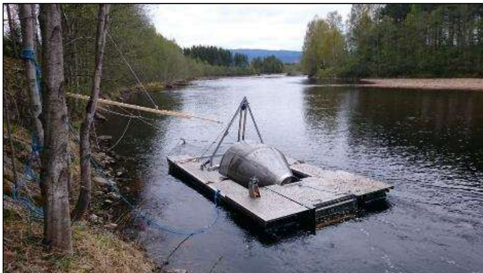
Figur 18. Plasseringen av skrufella i Heddøla ved Hustveit (Fellesfjøset) i 2017, på en dag med normal vannføring.
